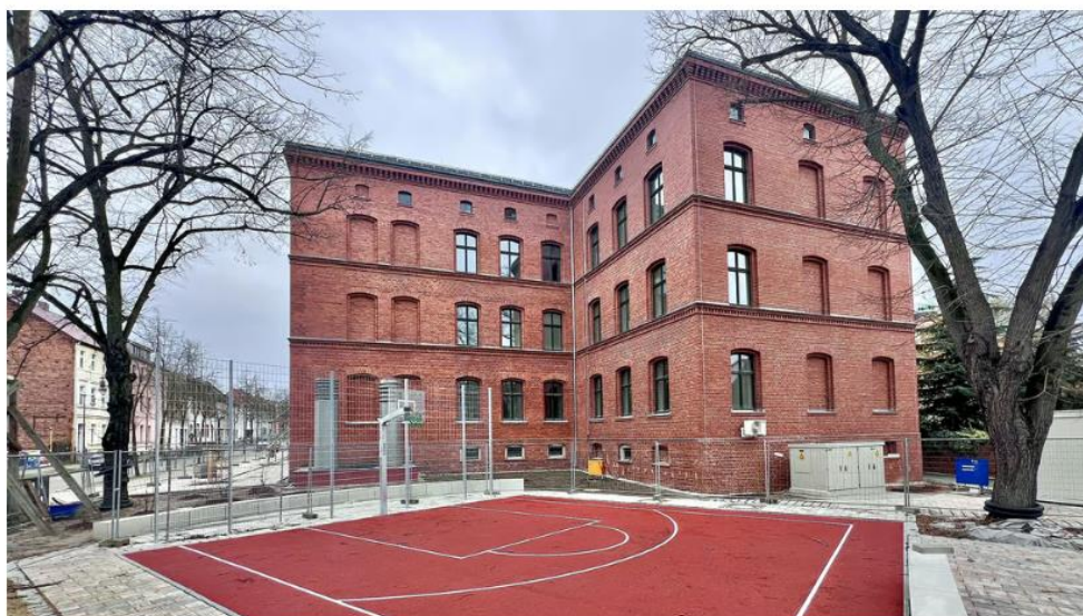
Baustellenbesuch in der Sekundarschule Roßlau Goethestraße: Auf dem Schulhof gibt es ein neues Basketballfeld. Foto: Thomas Ruttke
